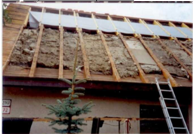
Obr.č. 1: Výměna minizolace po 20 letech
