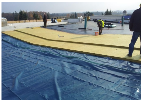
Obr. 6.3 Střecha na trapézovém plechu
